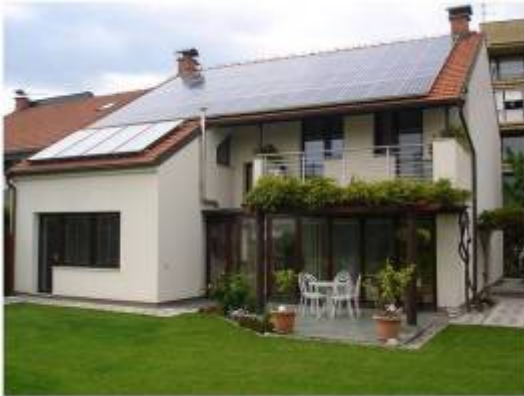
Solarni krov Špansko, Zagreb, 10 kW
